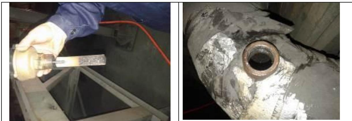
По результатам осмотра принято решение промывать котлы раствором средства «Антиржавин» концентрацией 1:5 в течение 6 часов в динамическом режиме, далее в течение 14 часов в статическом режиме.
